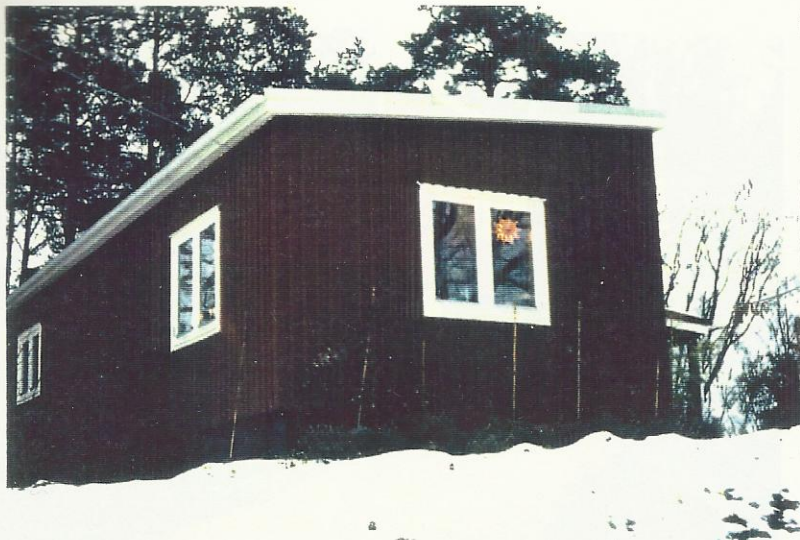
Utbyggnad av takfoten påverkar i hög grad utseendet. Avtäckningsplåt ska vara svart.
