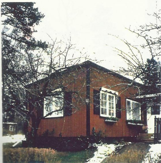
Svarta fönsterluckor, fönsteromfattningar och knutar samt pålimmade spröjsar känns främmande i Höjdhagen.
